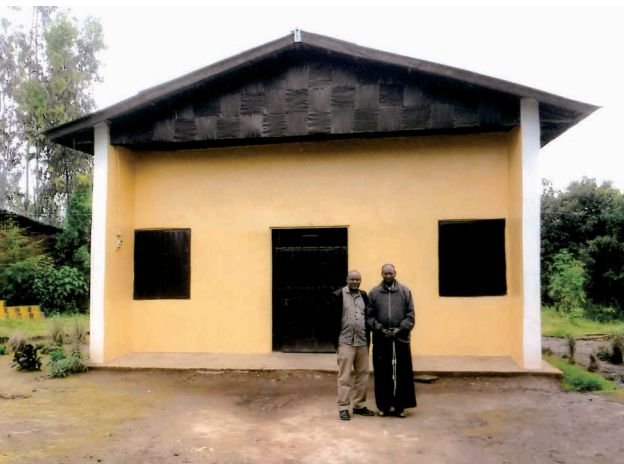
Wyremontowana kaplica, fot. arch. SSPC
